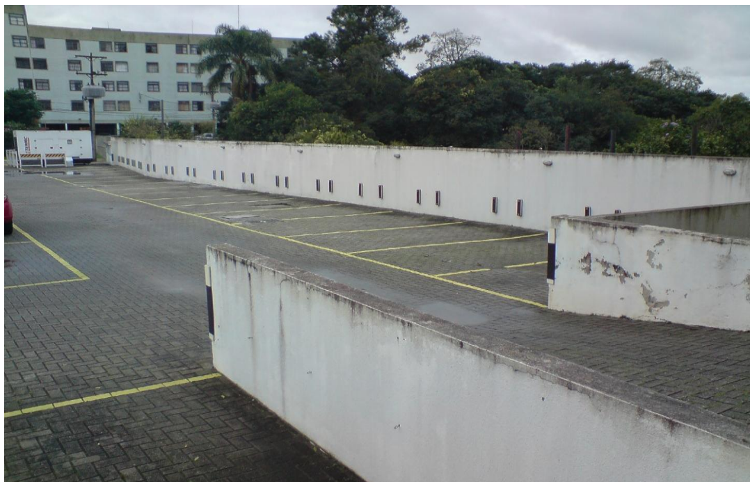
Figura 07 – Muros do estacionamento descoberto.
