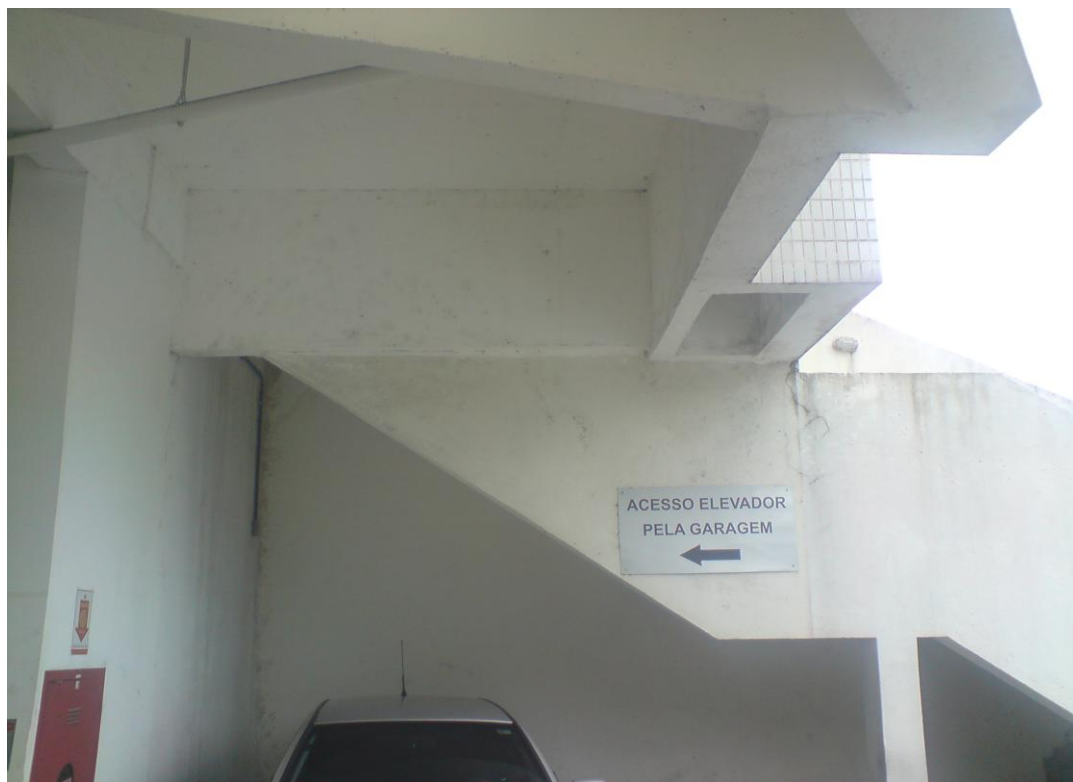
Figura 06 – Detalhe lateral do estacionamento coberto.
