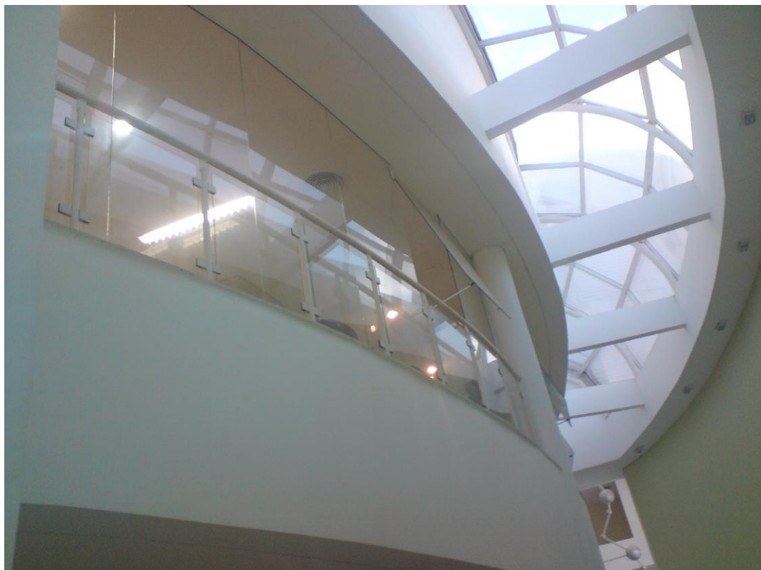
Figura 18 – Janelas internas, localizadas no 1º andar, no Gabinete da Diretoria.
