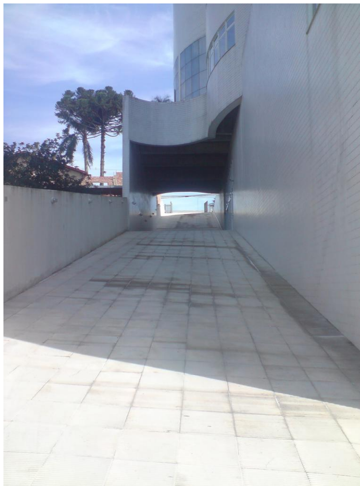
Figura 13 – Rampa de acesso.
