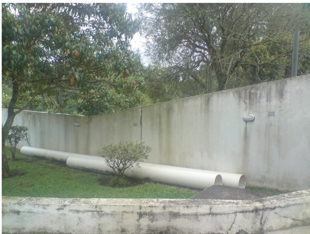
Figura 10 – Muro lateral do estacionamento descoberto.
