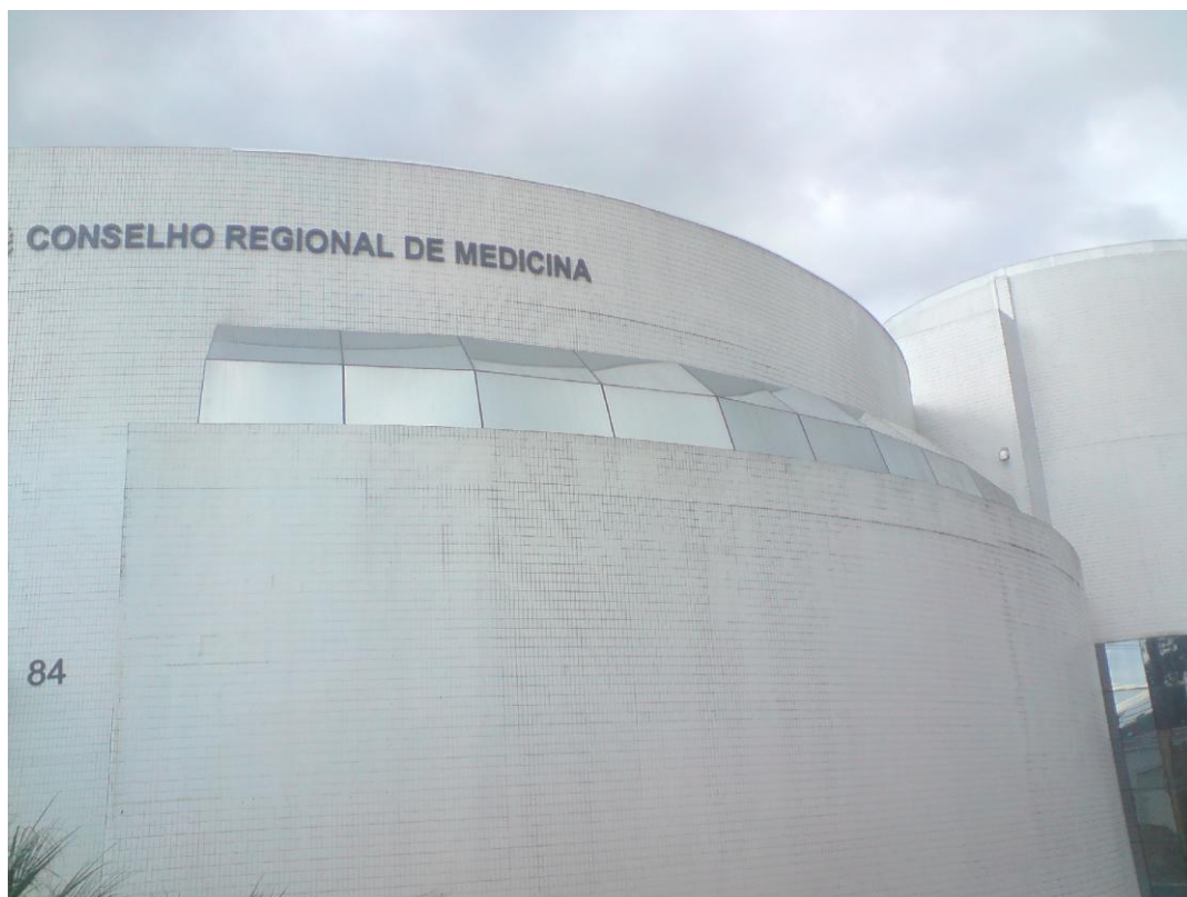
Figura 21 - Vista externa do teto de vidro do hall de atendimento localizado no piso térreo.
