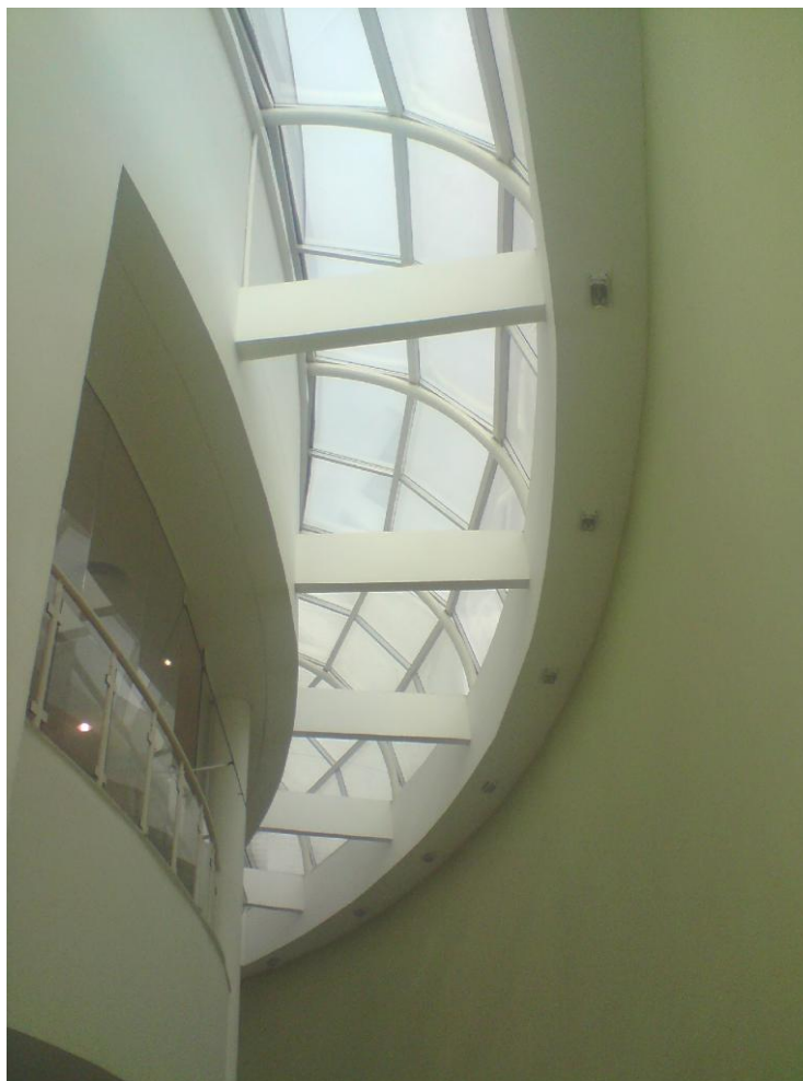
Figura 20 – Vista interna do teto de vidro do hall de atendimento localizado no piso térreo.
