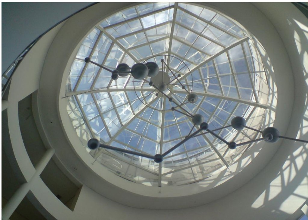
Figura 28 - MóBILE visto por baixo pelo piso S1.
