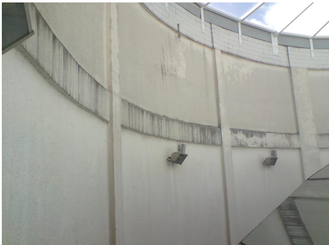
Figura 26 – Parede de alvenaria entre as cúpulas.
