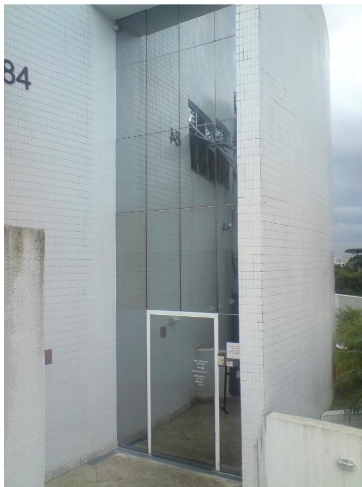
Figura 15 - Fachada externa da porta principal localizada no piso térreo.
