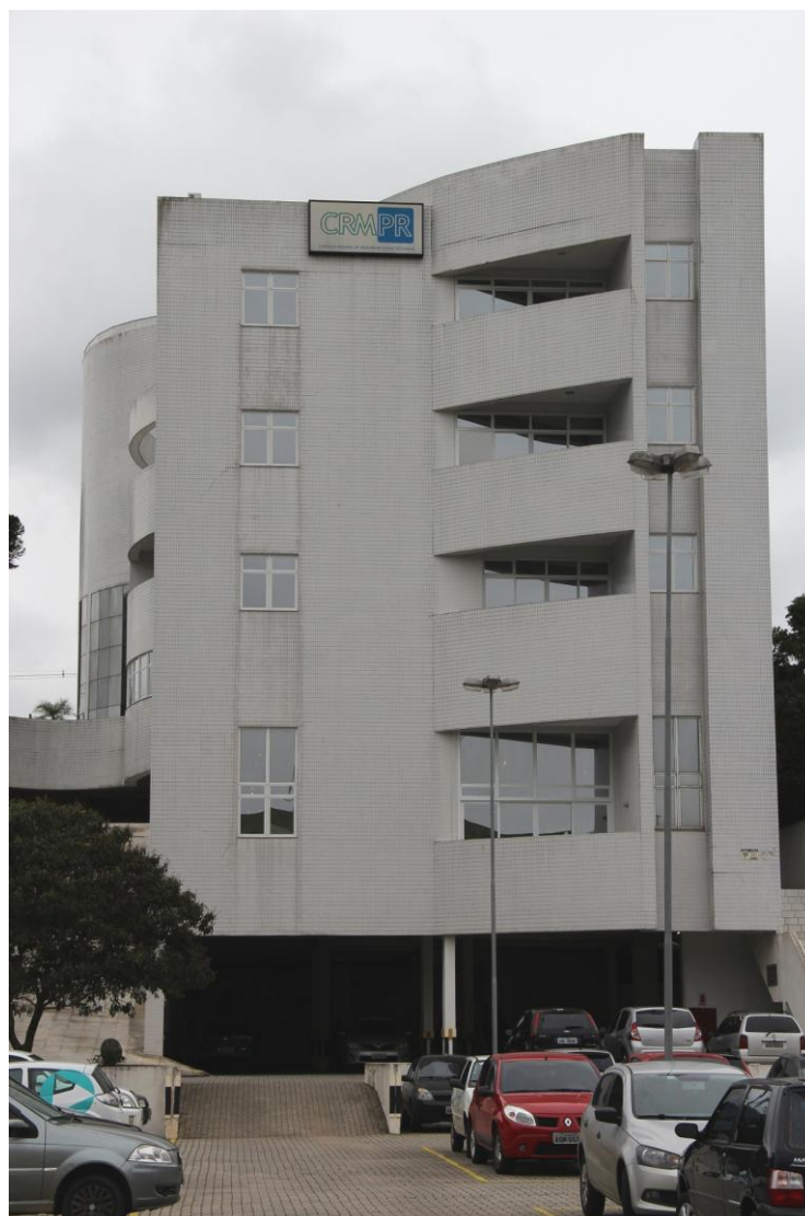
Figura 02 – Fachada de trás do prédio da Sede do CRM-PR.
