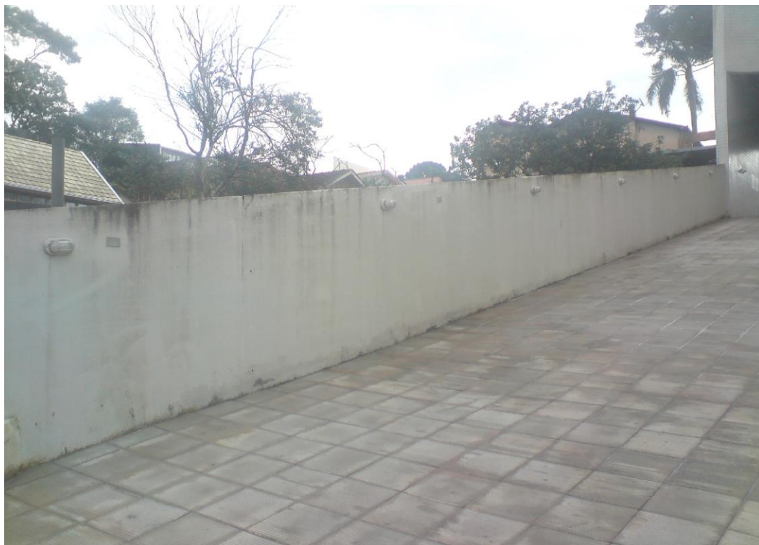
Figura 09 – Muro localizado ao lado da rampa de acesso ao estacionamento.
