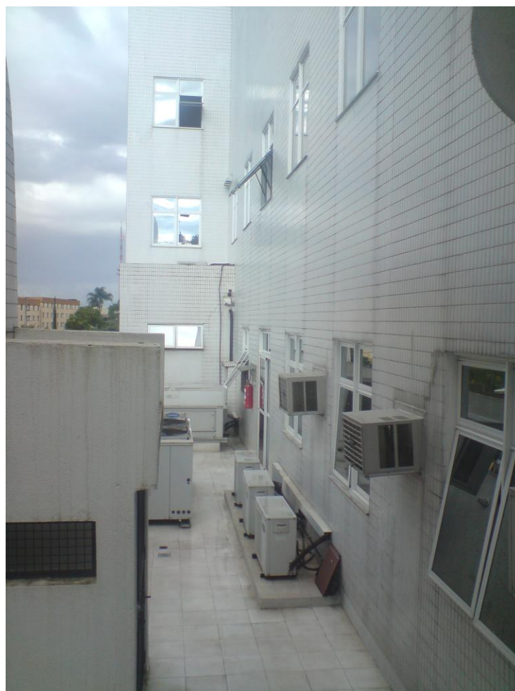
Figura 03 – Detalhe do pastilhamento do prédio.
