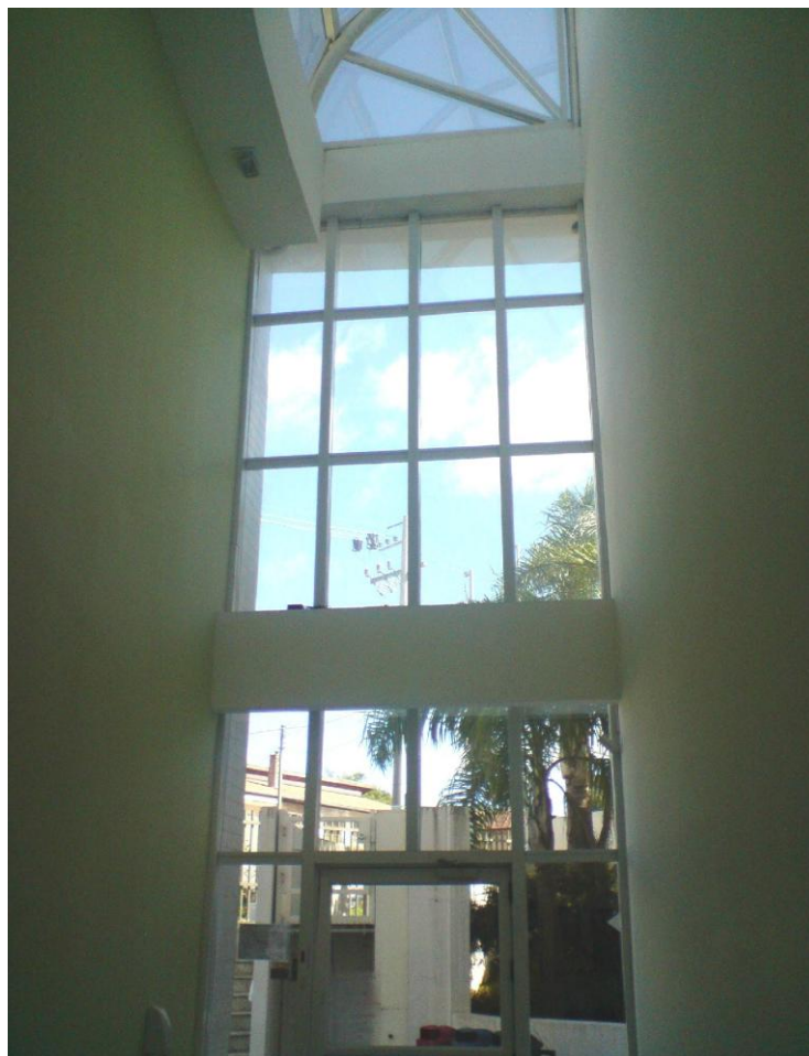
Figura 17 – Vista interna da fachada envidraçada da porta principal localizada no piso térreo.
