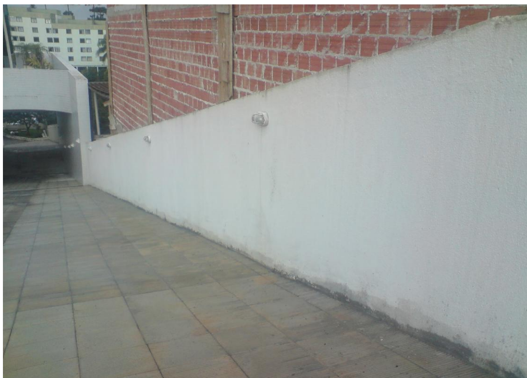
Figura 08 – Muro localizado ao lado da rampa de acesso ao estacionamento próximo à entrada principal.
