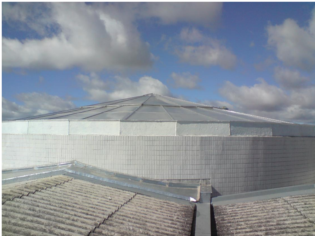
Figura 25 - Vista externa da cúpula maior (acrílico cristal compacto).
